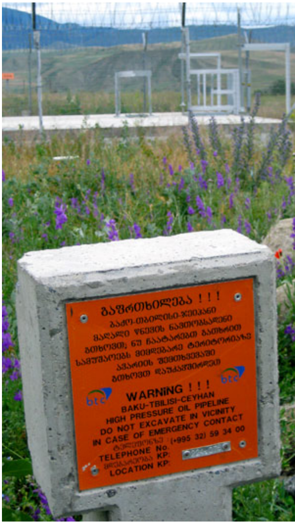
10. Une station de contrôle de l'oléoduc BTC près d'Akhalsikhe au sud-ouest de la Géorgie. © Photo Gérard-François Dumont - juin 2007.
